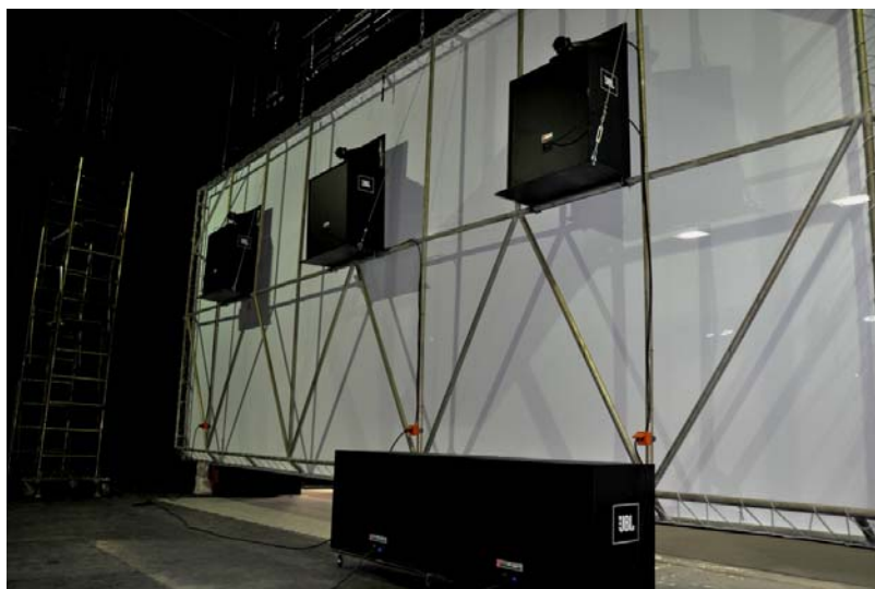
Sl. 6 - „Screen“ i „subwoofer“ zvučnički sistemi iza projekcionog ekrana u Velikoj sali DOB
